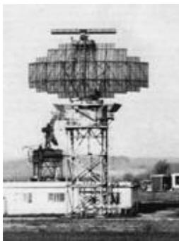
Le CDC de Narbonne inaugure sa nouvelle salle d'opérations classiquement équipée d'un filtre vertical. Ses radars sont trois antennes de site à balancement et un radar panoramique 23 cm (DRFV 13A) doté d'un effaceur d'échos lents (EEL) qui élimine efficacement les nombreux échos produits par le relief avoisinant, tout en permettant une excellente détection vers les approches maritimes.
