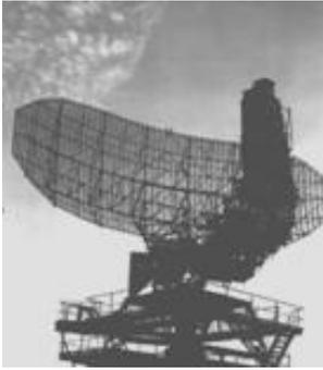
A Doullens, un radar volumétrique Palmier G est mis en service ; ce radar de THOMSON-CSF émet avec une puissance de crête de 20 Mégawatt en 14 lobes.
